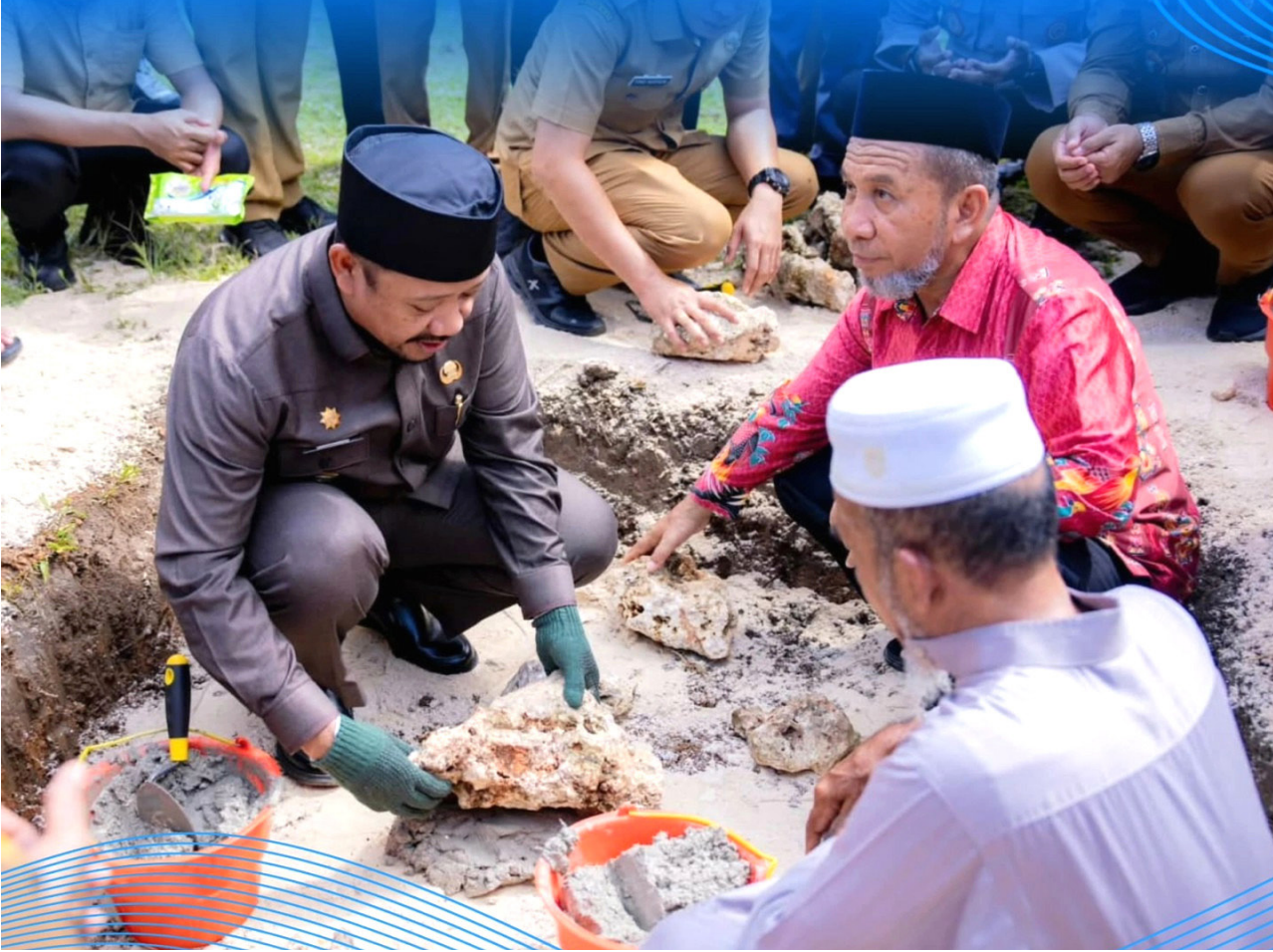
Bupati Buton Tengah, Dr. Azhari, S.STP., M.Si., melakukan peletakan batu pertama Pembangunan Masjid Al-Karim di Desa Wongko Lakudo, Kecamatan Lakudo Senin (6/4/2026)
